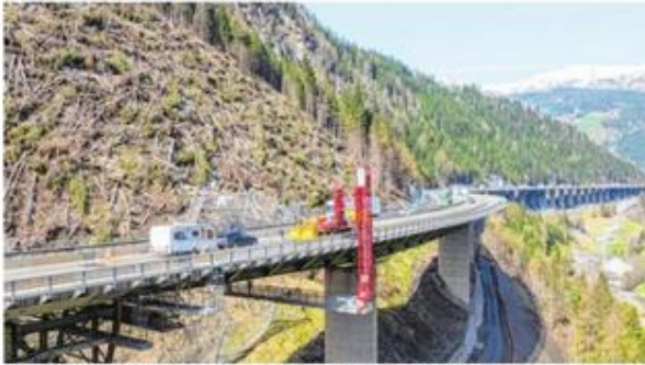
Mit einem Brückeninspektionsgerät wird noch im April jeder Quadratkilometer der Luegbrücke abgeklippt.
